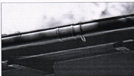
Два съседни улука се съединяват със спадка
