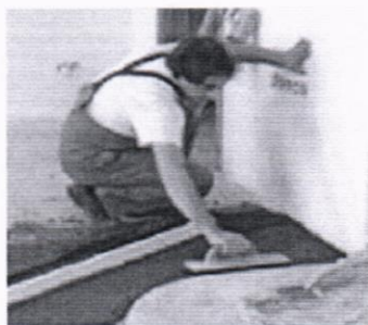
Фигура 1- Направа на изравнителна циментова замазка и водещи ивици.
