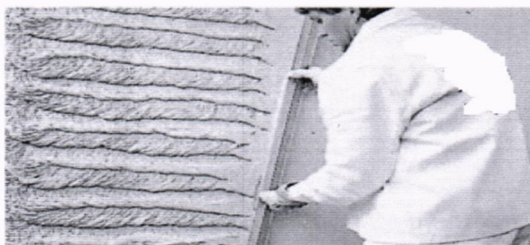
фиг. 2 Изтегляне на машинна мазилка
