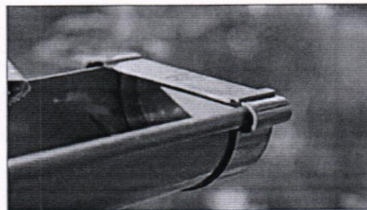
Краищата се затварят с тапи, които се залепват
