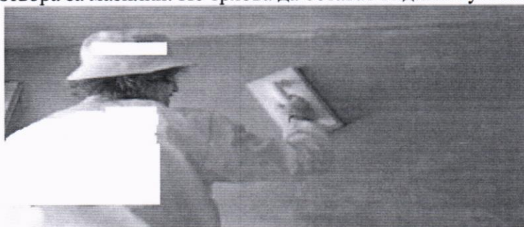
фиг. 4 Изпердашване на мазилка
