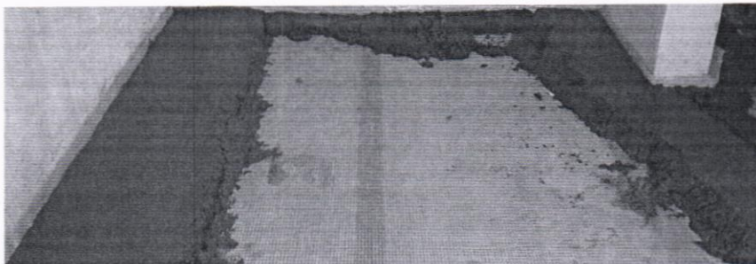
Фигура 1- Направа на изравнителна циментова замазка и водещи ивици.
